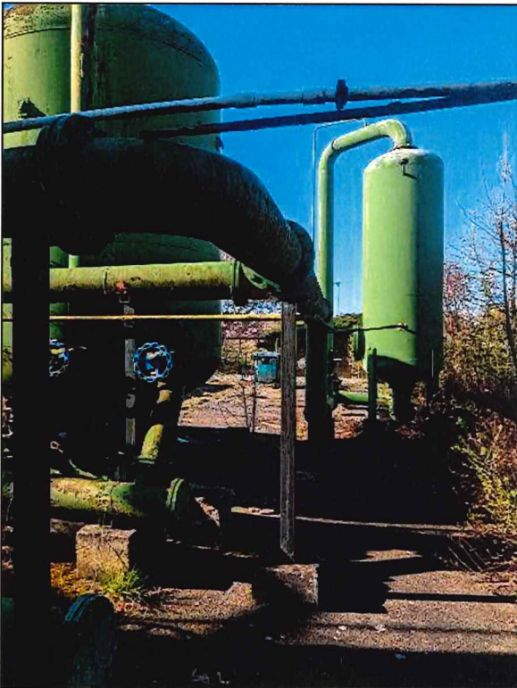
Zdjęcia 7-31. Stalowe zbiorniki - filtry żwirowe
